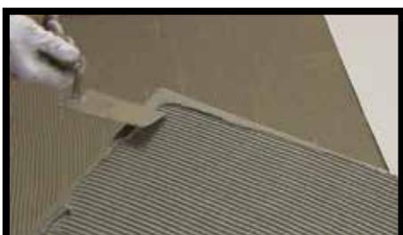
**Рис. 29.** Метод двойного нанесения, состоит в следующем. Клей наносится сплошным слоем на поверхность основы посредством шпателя с зубцами, расположенными на расстоянии 6 мм друг от друга (например, Raimondi арт. 138HFV6). Затем клей наносится на обратную сторону плитки шпателем с зубцами на расстоянии 3 мм. Следует распределить клей по всему периметру плиты.
