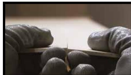
**Рис. 3.** После надреза достаточно слегка надавить на плиту, чтобы разделить обе части.
