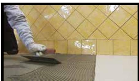
**Рис. 28.** Этот метод подходит только в случае использования клеев с рекомендацией производителя «укладка с одинарным нанесением». Нанести клей сплошным слоем на поверхность основы. Шпатель и способ нанесения выбираются в соответствии с инструкциями производителя клея.
