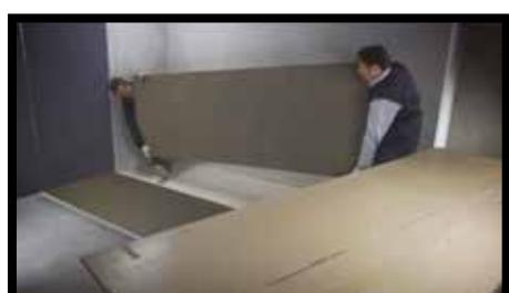
**Рис. 31.** Для перемещения плит сначала следует привести их в вертикальное положение, удерживая плиту за верхний край. После этого их можно переносить вдвоем при соблюдении вертикальности.
