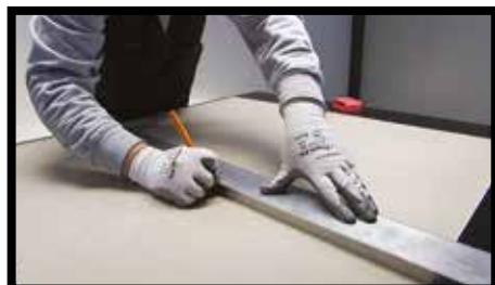
**Рис. 2.** Для получения максимально ровного среза можно воспользоваться алюминиевыми рейками, которые обычно применяются в строительстве.
