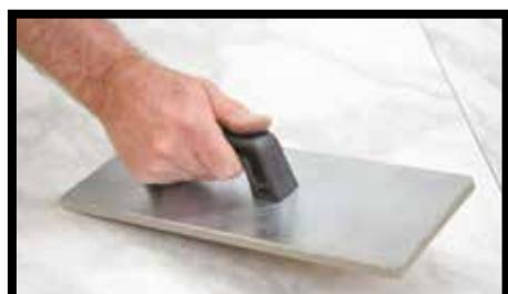
**Рис. 30.** После укладки плиты необходимо обеспечить равномерное распределение клея по всей ее поверхности во избежание образования пустот и пузырьков воздуха. В этих целях используются резиновые кельмы (гладилки) (например, Raimondi 142G).
