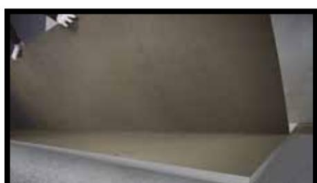
**Рис. 32.** Во время укладки плиту опирают на одну из длинных сторон, а затем опускают на основу.
